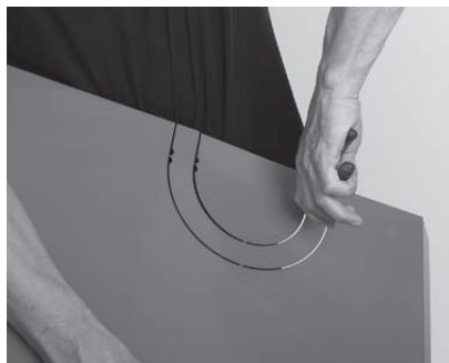
Fig. 79 Si aucun adaptateur pour raccord d'évacuation des fumées n'est utilisé, dégager l'orifice prédécoupé
