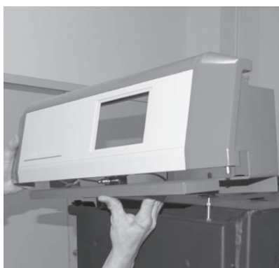
Fig. 34 Emboîter le tableau de distribution et la tôle de gaz de combustion
