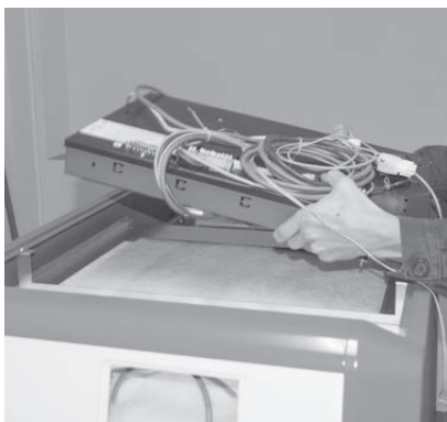
Fig. 47 Poser le tableau de distribution sur la chaudière
