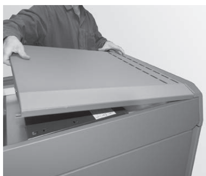
Fig. 96 Accrocher la jaquette de la chaudière
