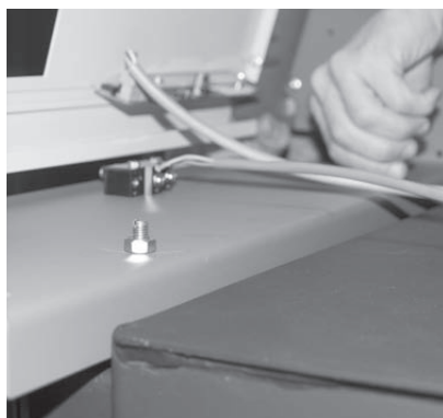
Fig. 35 Fixer sans serrer le tableau de distribution et la tôle de gaz de combustion avec respectivement 1 écrou M8
