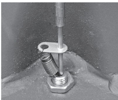
Fig. 56 Fixer la sonde Thermocontrol avec un ressort
