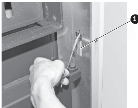
Fig. 55 Faire passer la sonde Thermocontrol 1..... Orifice prédécoupé - Passage
