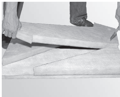
Fig. 42 Découper la partie prédécoupée, uniquement pour le modèle LogWIN Klassik pellet ready
