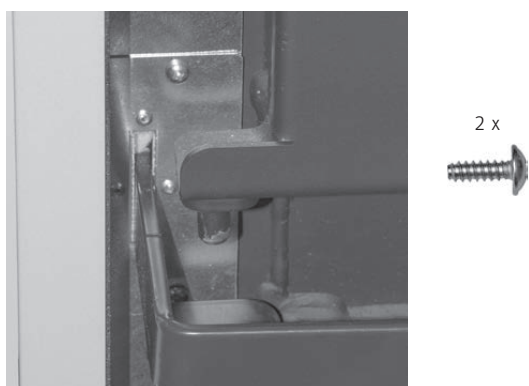
Fig. 52 Passage du levier de nettoyage des surfaces d'échange
