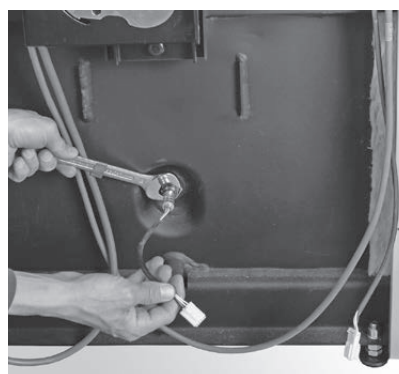
Fig. 44 Débrancher et dévisser la sonde lambda
