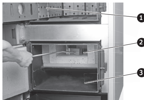
Fig. 32 Retirer les cendres de la chambre de combustion et du cendrier
