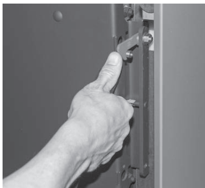
Fig. 7 Ouvrir le verrouillage de la porte du foyer
