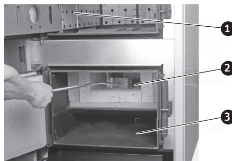
Fig. 55 Retirer les cendres de la chambre de combustion et du cendrier
