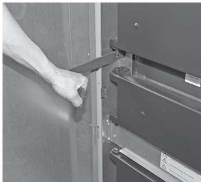
Fig. 40 Activer le levier de nettoyage des surfaces d'échange 5 à 10 fois LogWIN Klassik pellet ready
