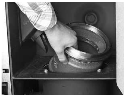
Fig. 43 Retirer le cône de partie inférieure
