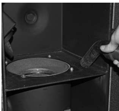
Fig. 41 Éliminer les résidus de combustion de la chambre de combustion
