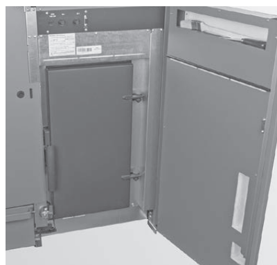
Fig. 5 Porte de revêtement ouverte
