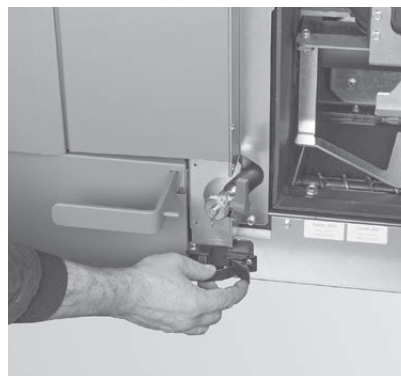
Fig. 35 Ouverture de la fermeture à étrier de tension
