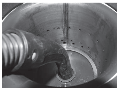
Fig. 55 Aspirer aussi les cendres du tube d'air primaire au milieu du creuset de brûleur
