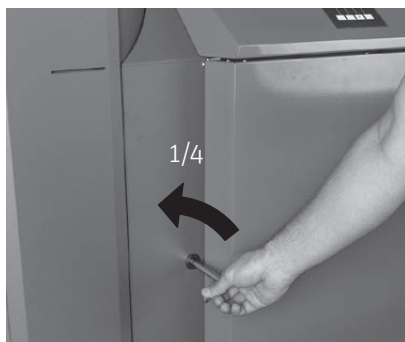
Fig. 5 Ouverture de la porte du revêtement à l'aide d'une clé à six pans creux
