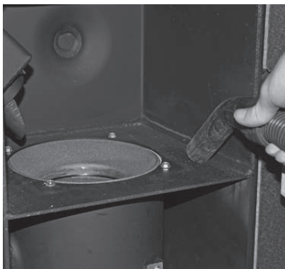
Fig. 46 Éliminer les résidus de combustion de la chambre de combustion
