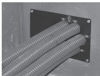
Fig. 19 Insérer les tuyaux – côté du silo
