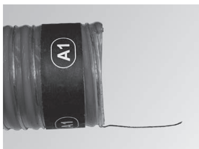
Fig. 18 Dénuder le fil de terre, coller l'autocollant avec inscription
