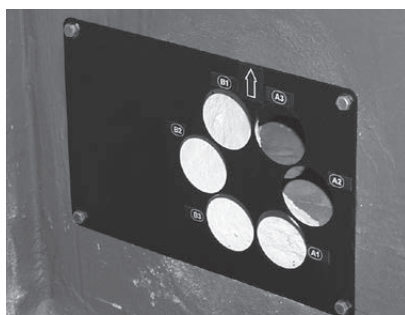
Fig.17 Monter la plaque de couverture provisoirement
