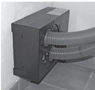
Fig. 27 Fixer les tuyaux à l'aide des colliers et monter la protection
