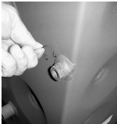
Fig. 5 Retirez la fixation de sonde
