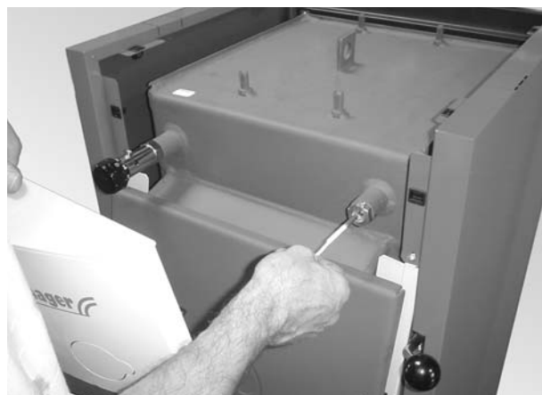
Fig. 21 Insérez la sonde du thermomètre dans la gaine d'immersion
