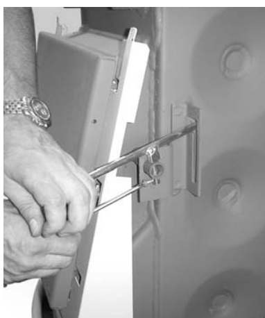
Fig. 14 Montez le levier de commande du clapet de préchauffage
