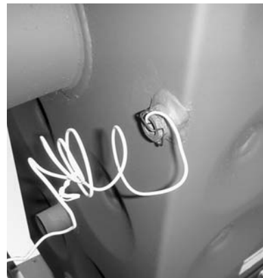
Fig. 7 Fixez la sonde avec la fixation de sonde
