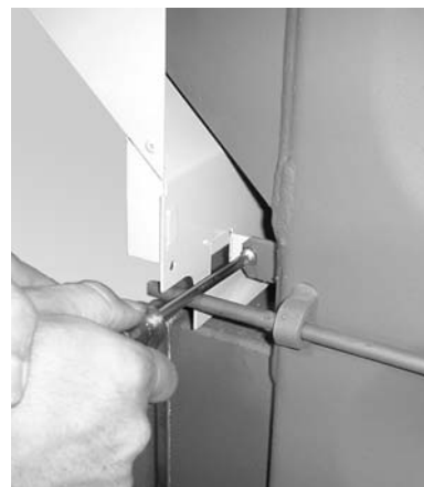
Fig. 13 Fixez la paroi avant en bas avec 2 vis
