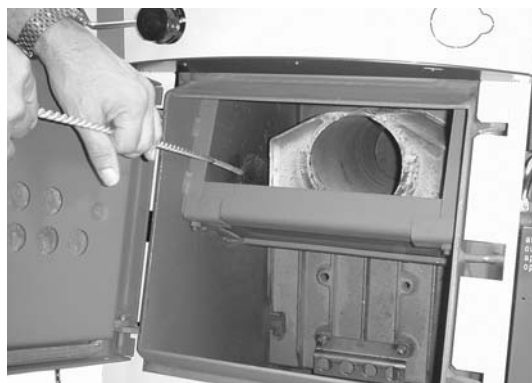
Fig. 13 Nettoyez les surfaces d'échange
