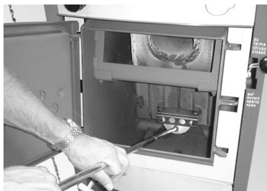
Fig. 15 Retirez le variateur de combustion, nettoyez la zone arrière
