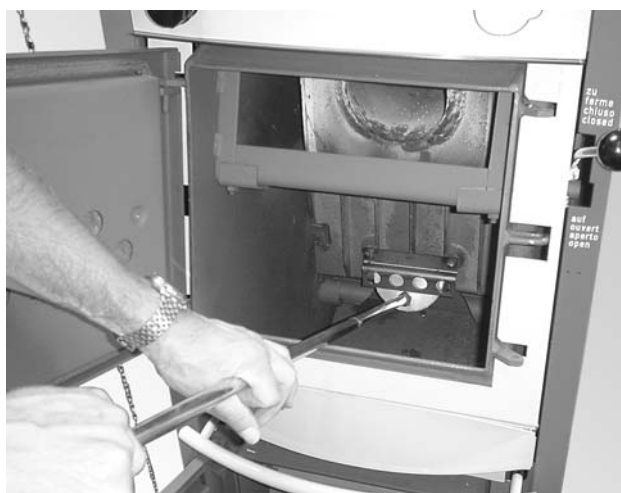
Fig. 10 Modification de la combustion
