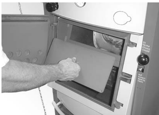
Fig. 12 Retirez le couvercle de nettoyage
