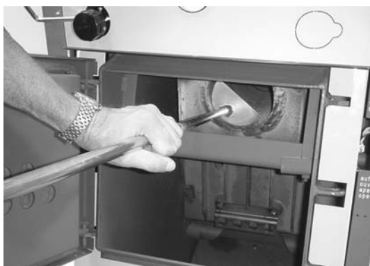
Fig. 14 Nettoyez le tube de fumée
