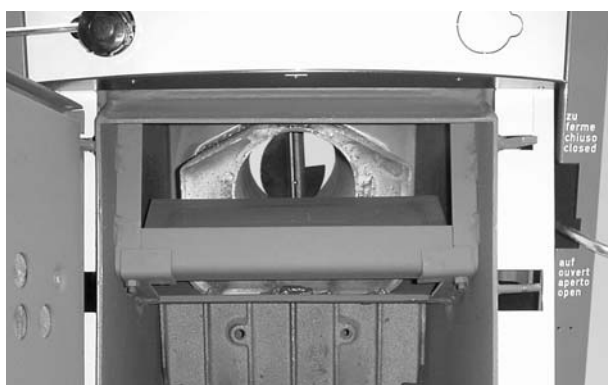
Fig. 7 Clapet de préchauffage ouvert, couvercle de nettoyage retiré
